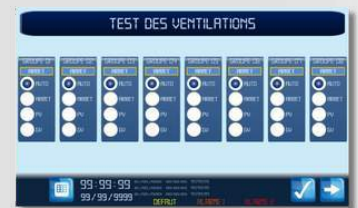
Etat des ventilations
